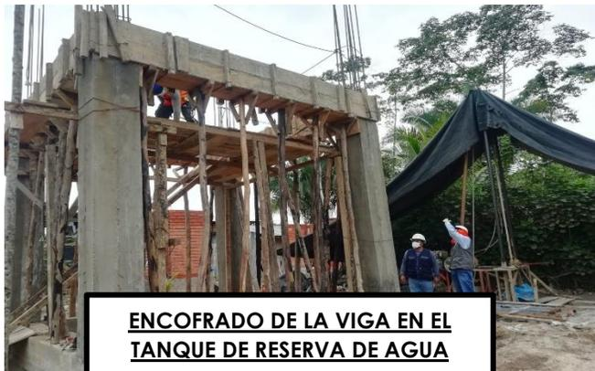
**ENCOFRADO DE LA VIGA EN EL TANQUE DE RESERVA DE AGUA**
