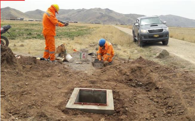
**TAPA DE CONCRETO ARMADO PARA POZO PERCOLADOR**
