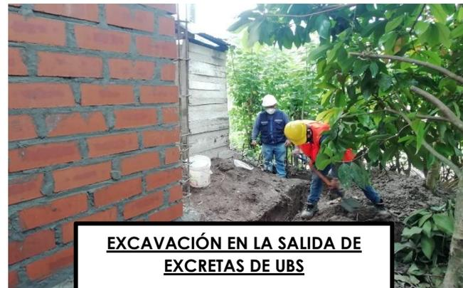
**EXCAVACIÓN EN LA SALIDA DE EXCRETAS DE UBS**
