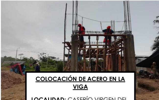
**COLOCACIÓN DE ACERO EN LA VIGA**
